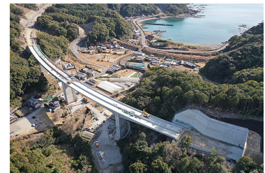
整備が進む「すさみ串本道路」
