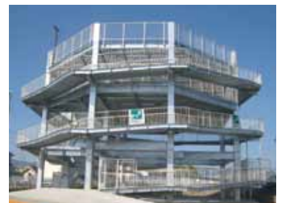
津波避難タワー
