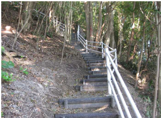
（完成した避難路）
