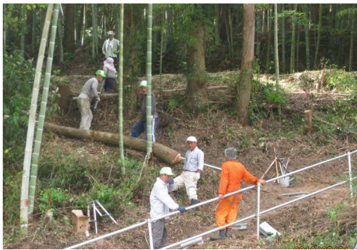
（避難路を整備している様子）
