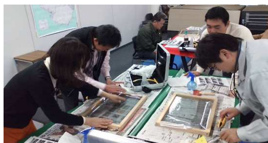
(エキスパートコース) (ガラスの飛散防止フィルム貼り)
