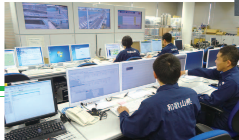
システム統制室
