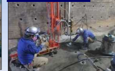
排水機場の耐震化
