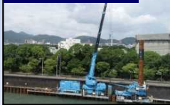
海岸堤防の耐震化
