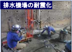
排水機場の耐震化
