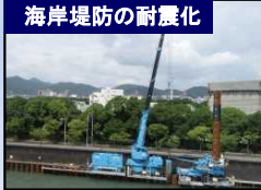
海岸堤防の耐震化
