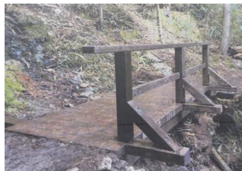
復旧後の状況
