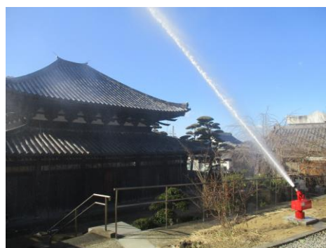
【国宝（建造物）】 善福院釈迦堂 防災施設整備（海南市）
