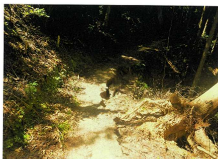
高野参詣道町石道の被災状況
