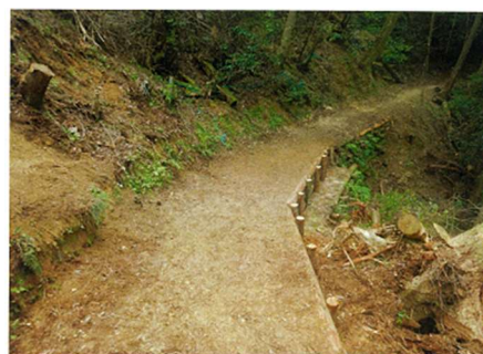
復旧後の状況
