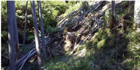
熊野参詣道潮見峠越の被災状況
