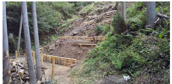
復旧後の状況
