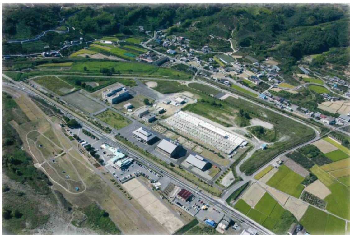
和歌山県下水道公社「伊都浄化センターパンフレット」
