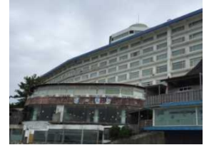
耐震改修前の同ホテル
