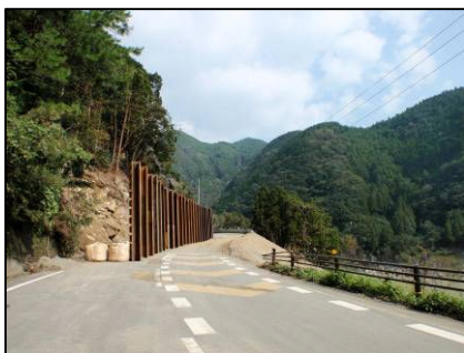
道路の応急復旧
