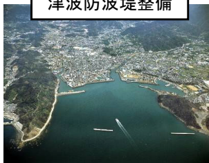
津波防波堤整備
