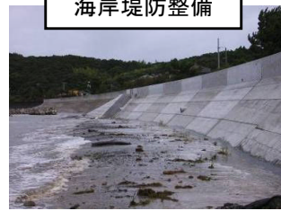
海岸堤防整備
