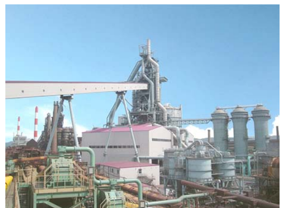
完成した新第1高炉
