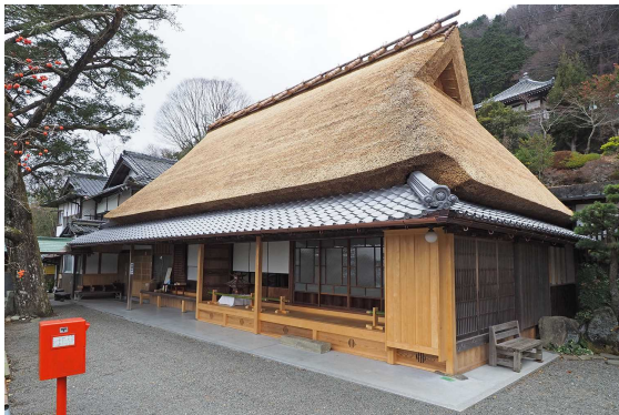
堀越齋観音庫裏（かつらぎ町）
