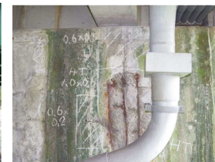
老朽化対策 コンクリートの剥離（橋脚）の補修
