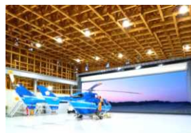
コスモパーク加太ヘリポート隣接地に整備 (令和4年竣工予定)
