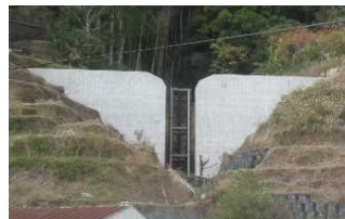
萩の谷川（田辺市）＜砂防堰堤＞
