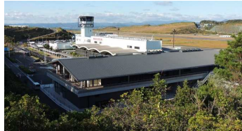
国際線ターミナルビル
