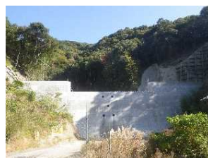
日高川町(岩垣内谷川) <砂防堰堤>
