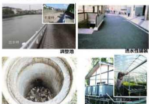
雨水貯留浸透施設の実例
