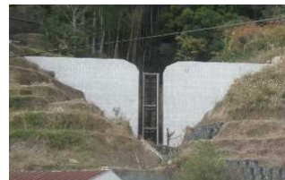
萩の谷川（田辺市）＜砂防堰堤＞
