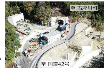
至古座川町 すさみ古座線（仮称小河内1号トンネル）
