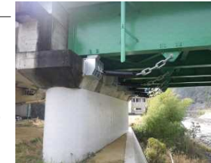
橋梁耐震化 落橋防止の設置
