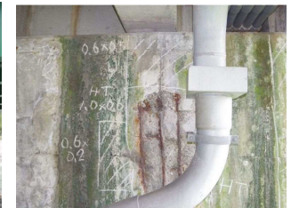
老朽化対策 コンクリートの剥離（橋脚）の補修
